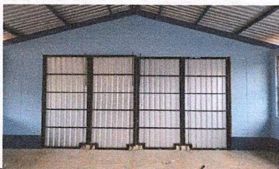
Foto 3: Se observa el cambio del techo y aplicación de pintura y cambio de laminas del centro educativo, (lijado de las estructuras y aplicacion de pintura y cambio de laminas)
