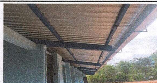
Foto 6: Se observa el mantenimiento preventivo de las estructuras metalicas del centro educativo.( lijado, aplicación de pintura antioxidantes, cambio de canale de aguas pluviales)
