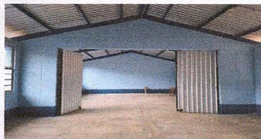
Foto 2: Se realizó mantenimiento preventivo a las estructuras del techos del centro educativo. ( Lijado y aplicación de pinturas antioxidantes de las costaneras
