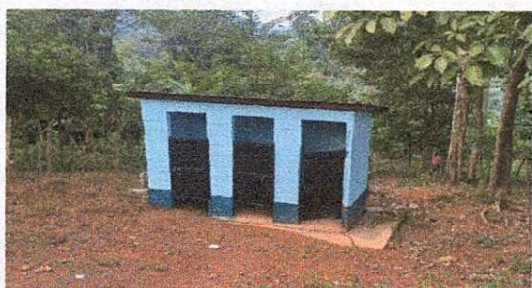
Foto 5: Se observa el mantenimiento preventivo de los sanitarios correspondientes del centro educativo. (lijado, aplicación de pintura en las paredes y puertas)
