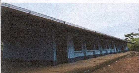
Foto 1: Se observa el cambio de los canales pluviales y se aplico pintura interior y exterior de los muros del modulo educativo
